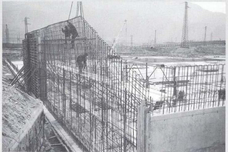
*Disposizione ferri e casseratura dei setti in cemento armato*
